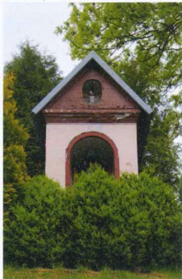
widok od strony zachodniej
