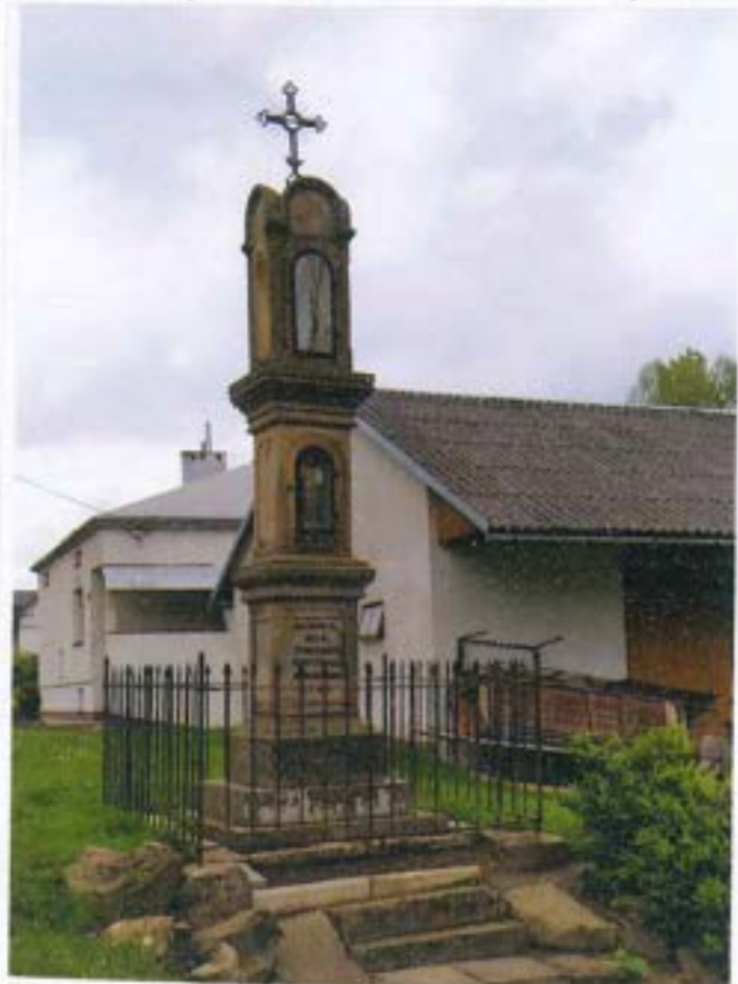
widok od strony północno-zachodniej
