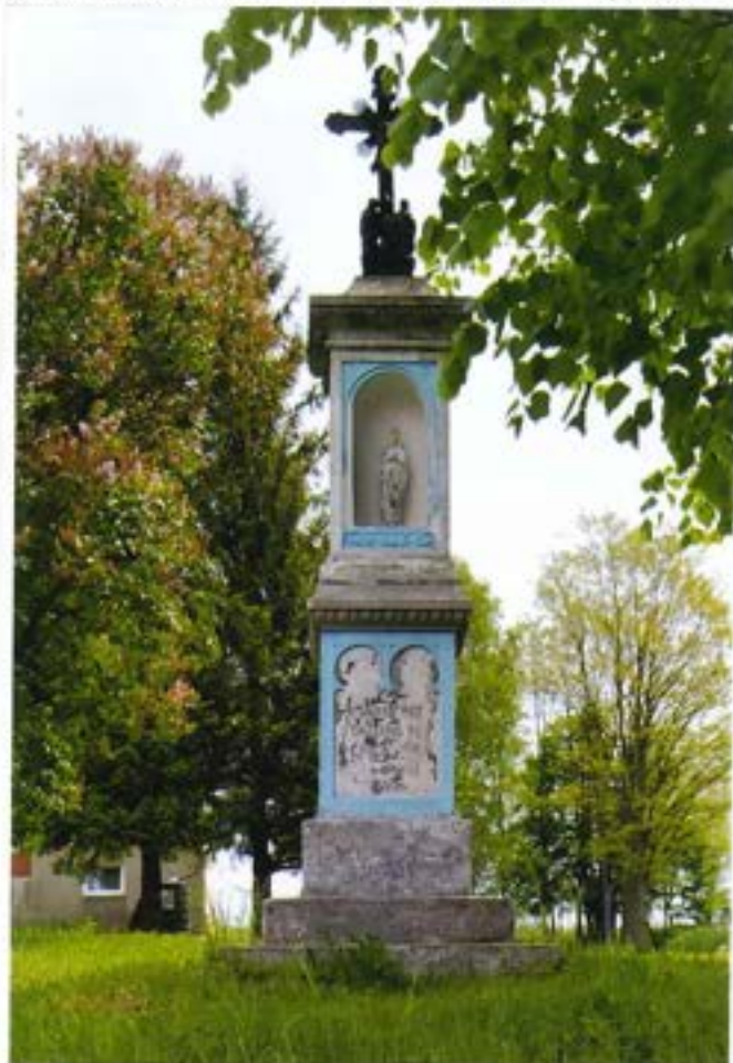
widok od strony zachodniej
