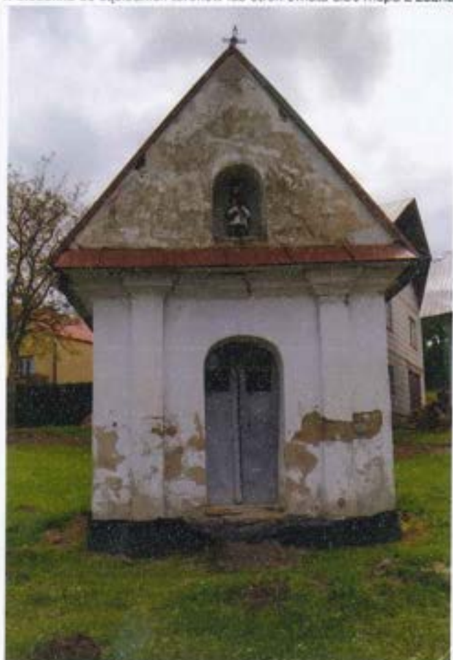
widok od strony zachodniej
