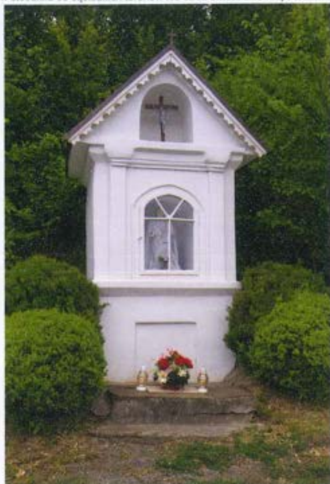
widok od strony południowej
