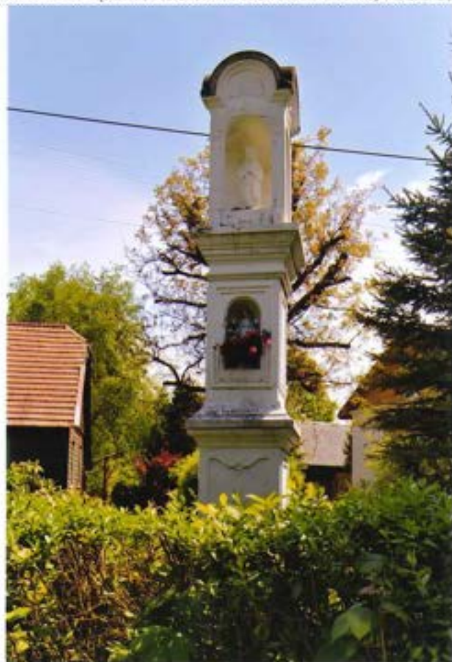
widok od strony zachodniej
